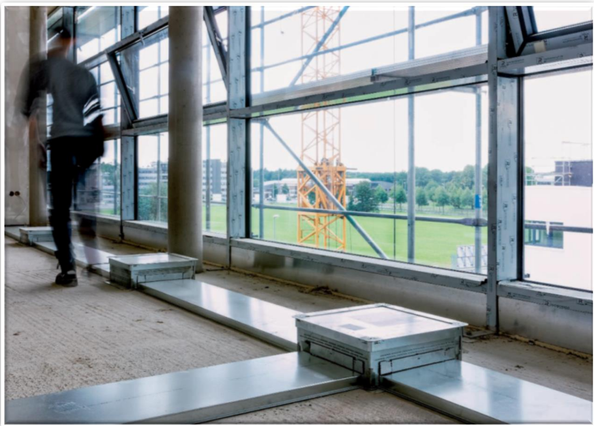
Obr. 6 : Príprava a koordinácia podlahového systému
