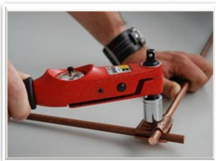
Obr. 4 Kontrola skrutkových spojov po skúške bleskovým prúdom
