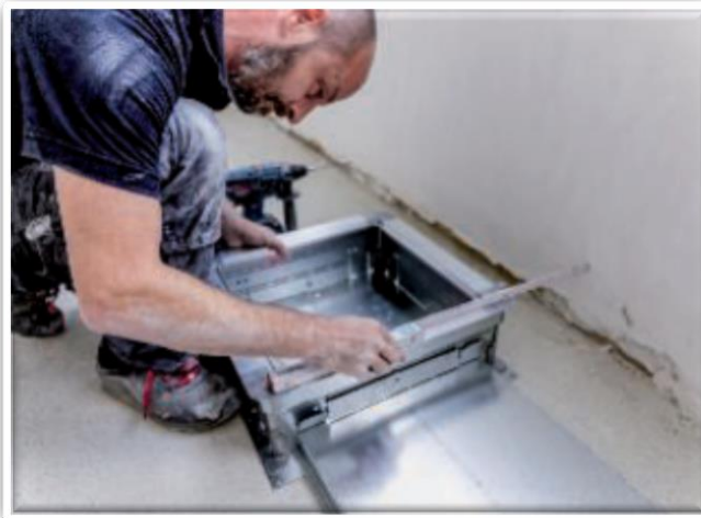
Obr. 8 : Nivelácia podlahového systému
