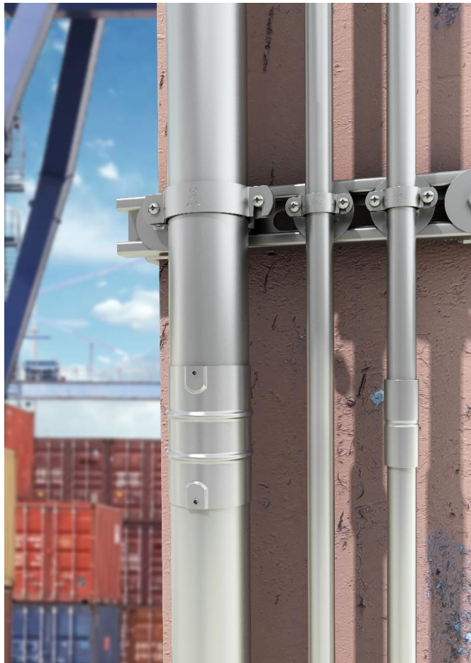
Obr. 11: Príklad montáže kovových rúrok
