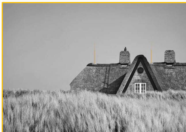
Obr. 16: Stavba s mäkkou strechou a zachytávacími tyčami
