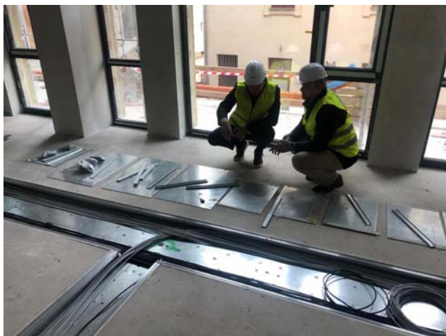
Obr. 4: Inštalácia káblových vedení
