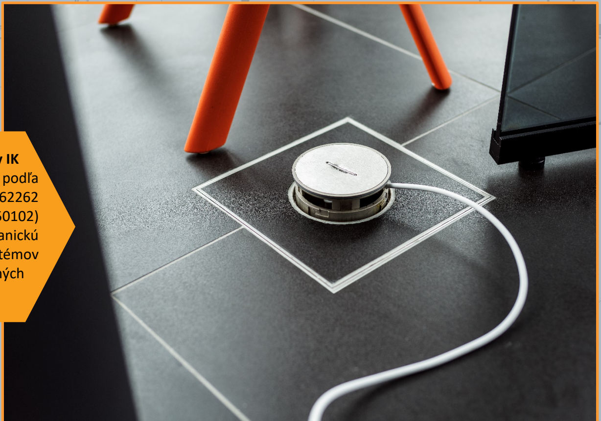
Obr. 5: Uloženie podlahovej krabice v keramickej podlahe
