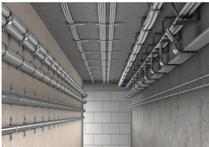
Obr1. : Príklad montáže OBO príchytiel
