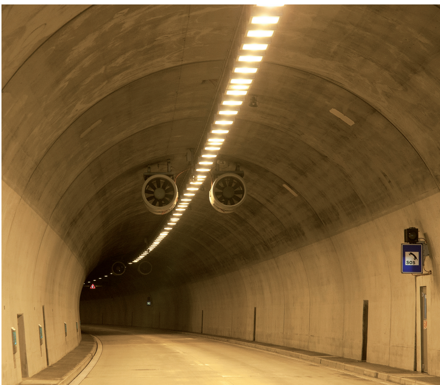
Obr. 8 Tunel Bôrik (zdroj: OBO Bettermann, s. r. o.)
