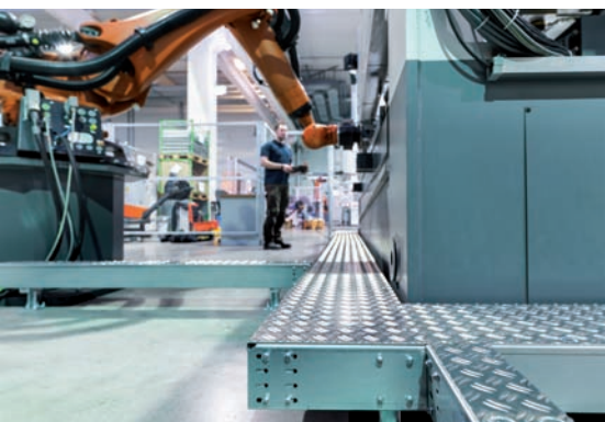
Pochôdzny káblový žlab zaručuje bezpečnú prácu vo výrobnom priemysle.
