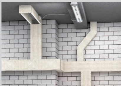
Montáž protipožárního kanálu na stěnu a strop
