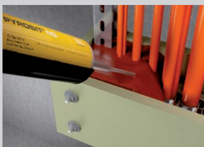
Zaplnění prostoru mezi kabely protipožární pěnou PYROSIT® NG.
