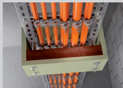
Zaplnění namontovaného pouzdra pěnovými bloky PYROPLUG® Block.
