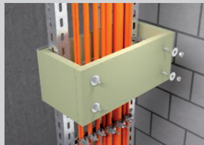
Upevnění předem smontovaného třístranného pouzdra k závitovým tyčím.
