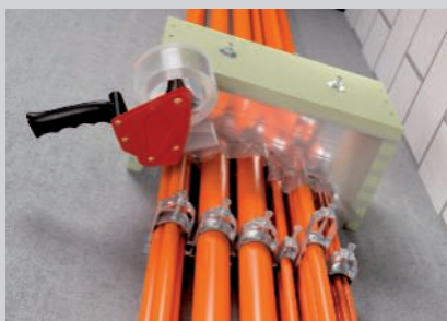
Zhotovení bednění pro bezpečné zaplnění pouzdra.
