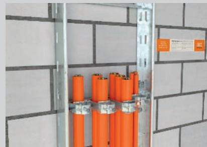
Upevnění jednotlivých kabelů nebo kabelů ve svazku pomocí třmenových příchytěk.
