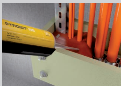
Zaplnění celého pouzdra protipožární pěnou PYROSIT® NG při velkém obsazení kabely.
