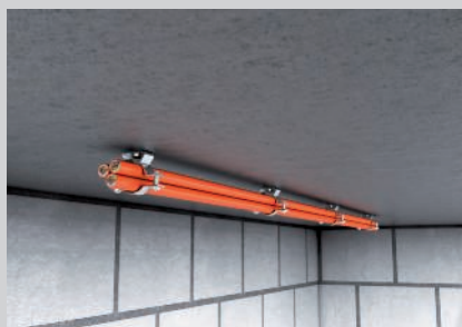
Uložení svazku kabelů pod strop.
