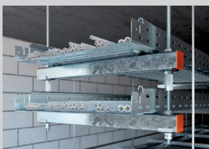
Montáž na strop ve dvou vrstvách nad zavěšený protipožární strop.
