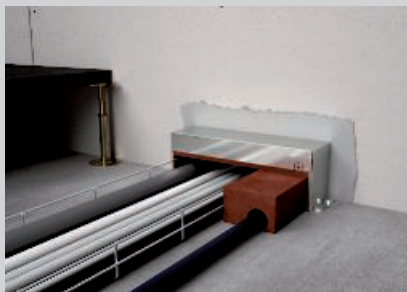
Vložení zkráceného vkládacího bloku do větších dutin
