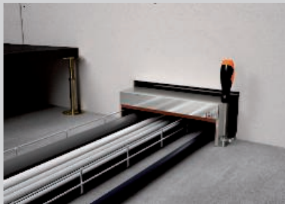
Vsazení krabice do otvoru ve stěně a upevnění k podlaze
