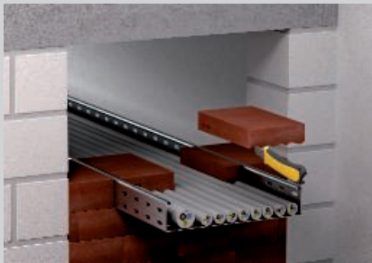
Montáž bloků zaříznutých na potřebnou velikost.
