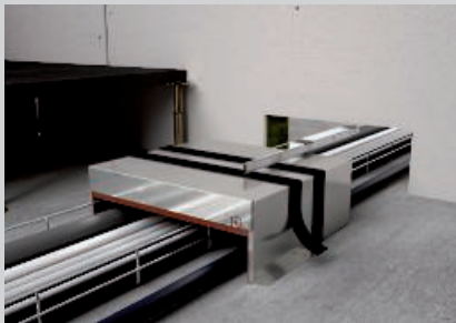
Změřte tloušťku stěny a v odpovídající vzdálenosti naneste grafítové pásky
