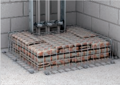
Zabezpečení proti sklouznutí nad podlahou.
