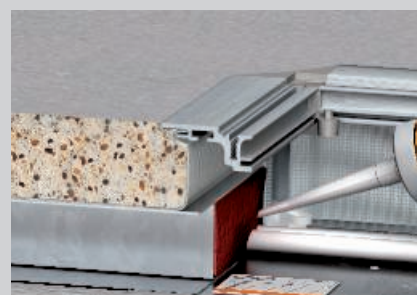
Uzavření zbytkových spár mezi kabely a bloky stěrkovou hmotou FBA-SP.
