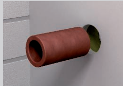
Vložení obalové trubky do lehké přepážky.
