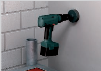
Vyvrtní otvoru pomocí jádrového vrtáku.
