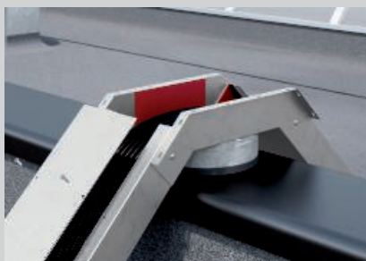
Montáž víka kanálu po uložení kabelů.
